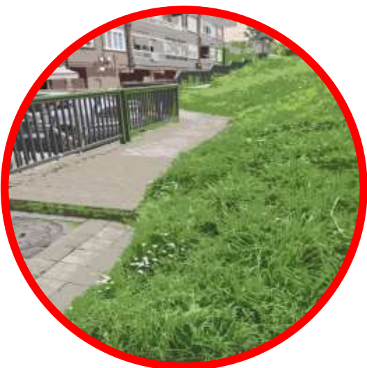
2. JARDUKETA: HIRUMUGARRIETA KALEA ACTUACIÓN 2: CALLE HIRUMUGARRIETA
