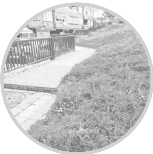
2. JARDUKETA: HIRUMUGARRIETA KALEA ACTUACIÓN 2: CALLE HIRUMUGARRIETA
